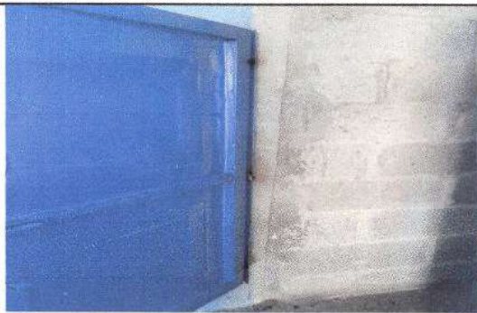
Foto 1: Colocacion de puertas de baños
