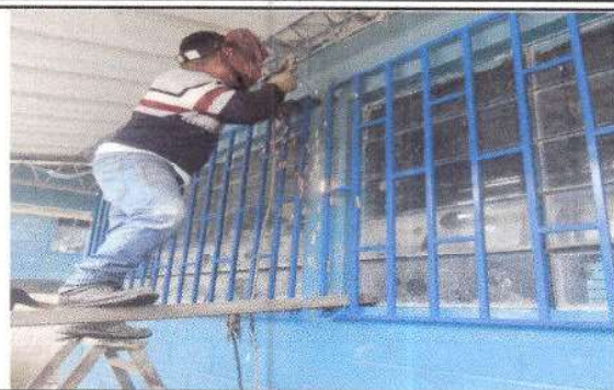
Foto 2: Colocacion de vidrios y balcones
